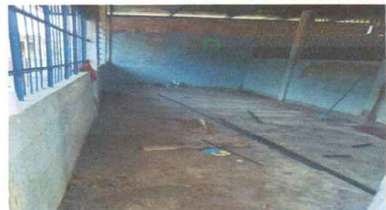
Foto 18: PISO TORTA DE CONCRETO
