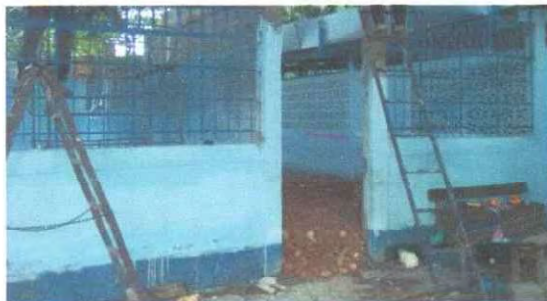
Foto 17: PISO TORTA DE CONCRETO EN 2 AULAS
