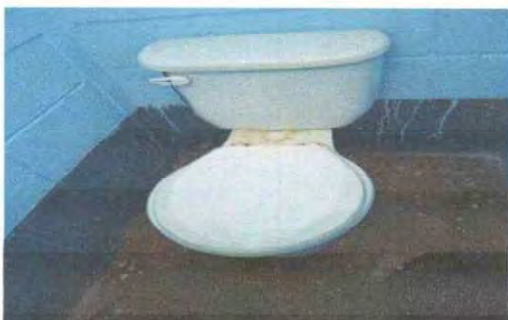
Foto 9: SUSTITUCIÓN DE INODORO
