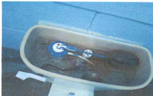
Foto 1: SUSTITUCIÓN DE ACCESORIOS DE INODORO
