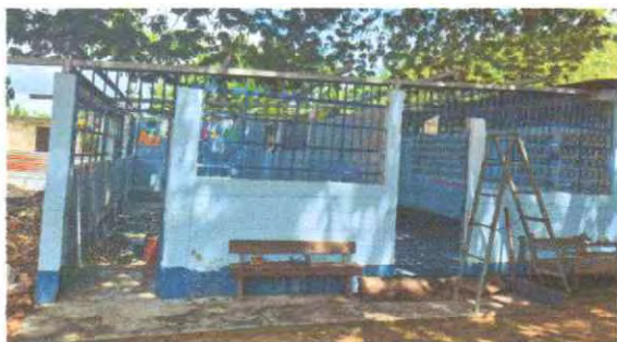
Foto 5: MANTENIMIENTO A ESTRUCTURA
