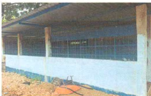
Foto 11: MANTENIMIENTO DE BALCONES DE METAL
