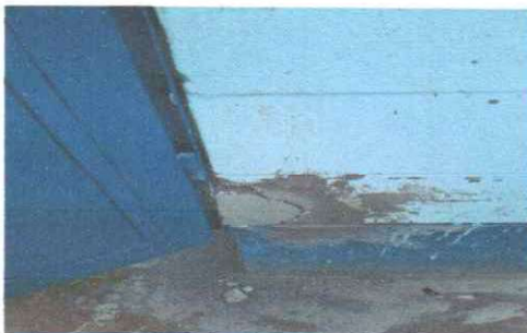
Foto 7: SUSTITUCIÓN DE PUERTAS EN SERVICIO SANITARIO
