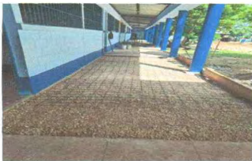
Foto 15: SUSTITUCIÓN DE PISO TORTA DE CONCRETO
