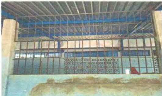
Foto 19: SUSTITUCIÓN A ESTRUCTURA DE METAL EN VENTANA
