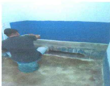
Foto 3: SUSTITUCIÓN DE MIGITORIO
