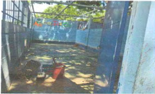
Foto 13: MANTENIMIENTO A ESTRUCTURA DE SOPORTE DE METAL
