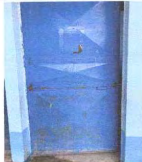
Foto 4: Mantenimiento de puerta
