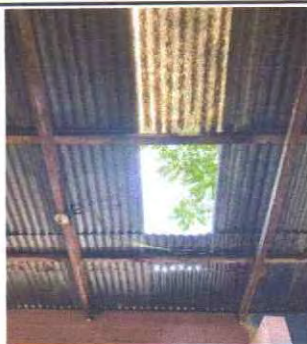
Foto 1: Sustrucción de lámina troquelada
