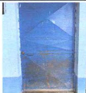
Foto 5: Mantenimiento de puerta
