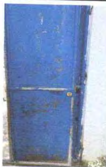
Foto 1: Mantenimiento a porton de metal
