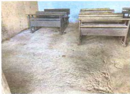
Foto 3: Reparación de torta de concreto
