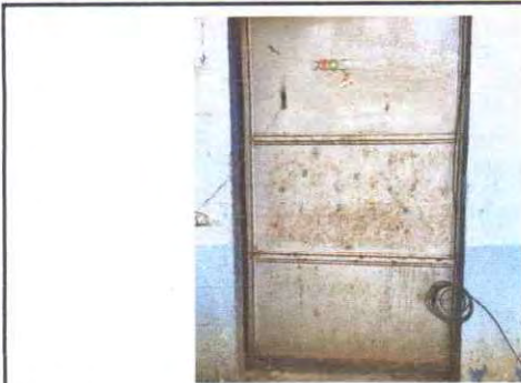
Foto 1: Mantenimiento de puerta
