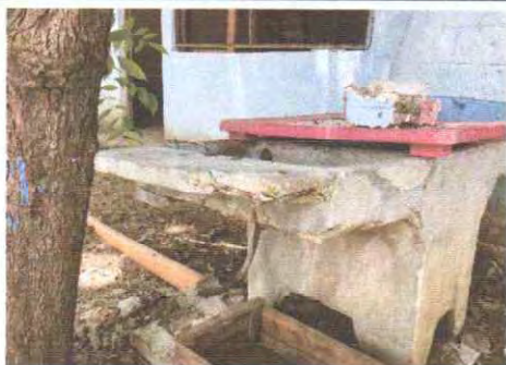
Foto 1: Sustrucción de pila de cemento de 2 lavadores
