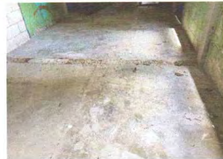
Foto 4: Reparación de torta de concreto
