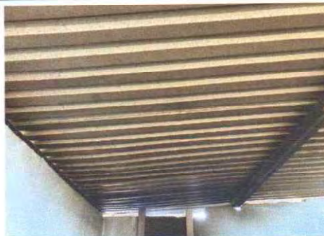
Foto 2: Mantenimiento de estructura de soporte de metal
