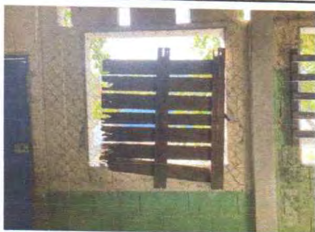
Foto 3: Fabricación e instalación de ventanas-balcon de metal
