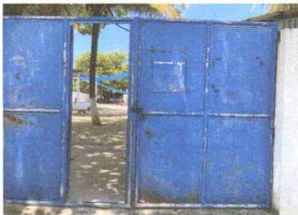
Foto 5: Mantenimiento a porton de metal
