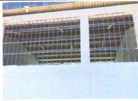
Foto 2: Mantenimiento de balcones de metal
