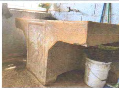
Foto 2: Sustrucción de pila de cemento de 2 lavadores
