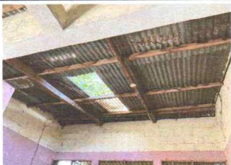
Foto 3: Mantenimiento de estructura de soporte de madera por metal
