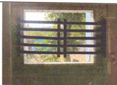
Foto 4: Fabricación e instalación de ventanas-balcon de metal
