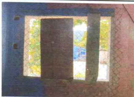
Foto 5: Fabricación e instalación de ventanas-balcon de metal
