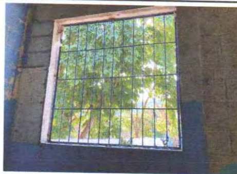
Foto 2: Fabricación e instalación de ventanas-balcon de metal
