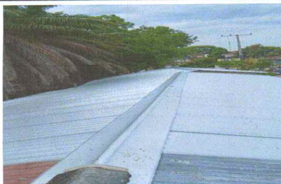
Foto 3: techo terminado area de cocina
