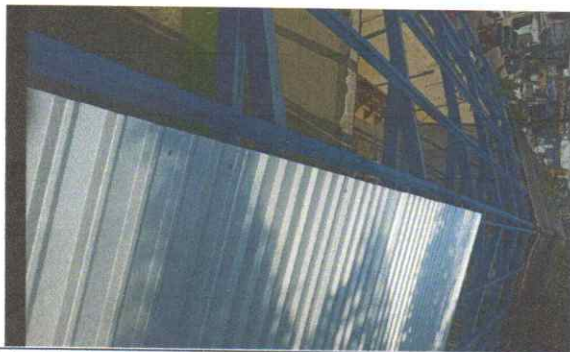
Foto 5: instalación de costaneras terminado e inicio de colocación de lámina
