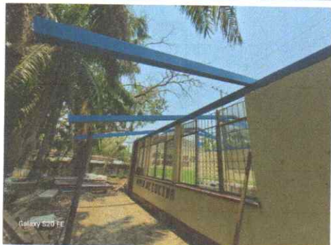
Foto 1: area de cocina inicio de la colocación de costaneras
