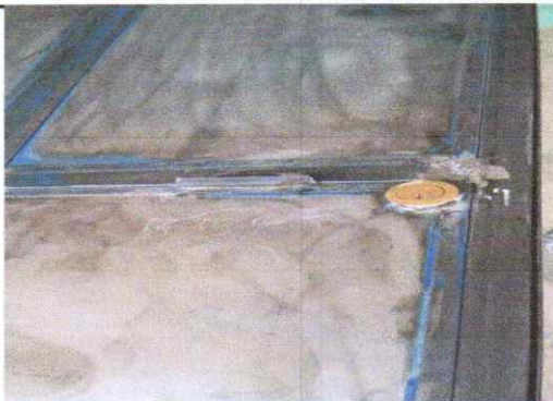
Foto 3: Sustitución de chapas
