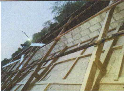
Foto1: Sustitucion de lamina por lamina de aluzinc calibre 26
