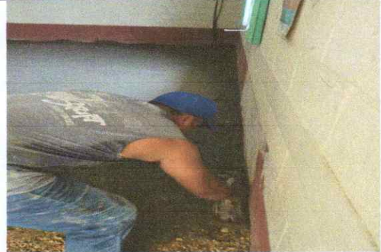
Foto 2: Sustitucion de piso de torta de concreto
