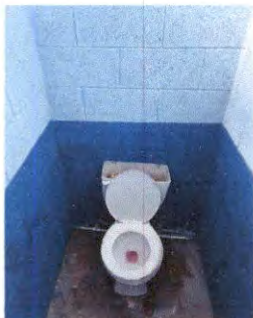
Foto1: Sustitucion de inodoros
