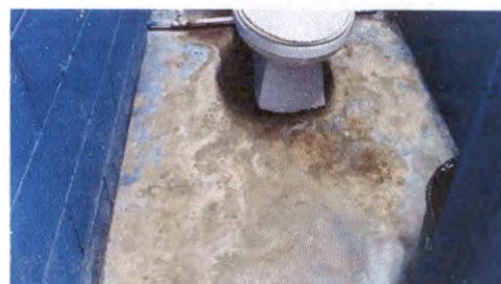
Foto 4: Reparacion de piso, torta de cemento en servicios sanitarios
