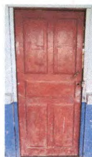
Foto 6: Sustitucion de puera de madera por metal
