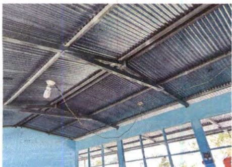
Foto 3: Reparacion de sistema electrico
