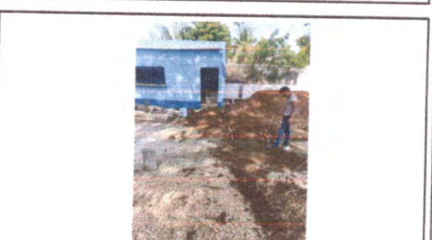
Foto 10: sustitución de tubería lineal principal
