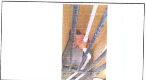
Foto 9: sustitución de bomba de agua
