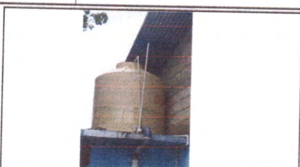
Foto 8: sustitución de deposito de agua
