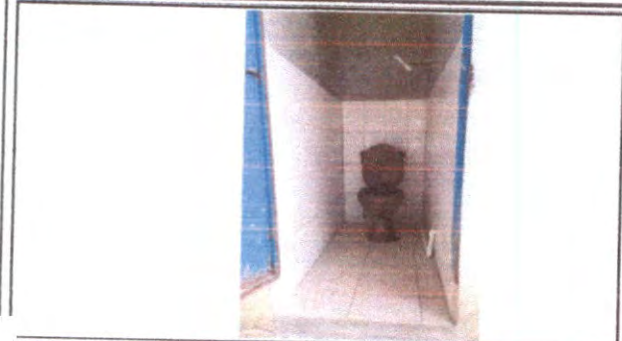
Foto 7: sustitución de inodoros (tasas)
