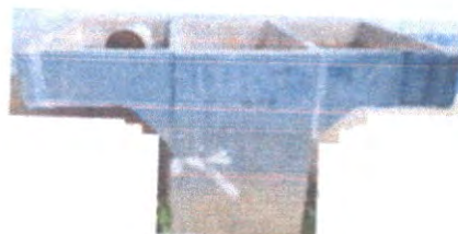
Foto 12: sustitución de pila
