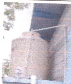
Foto 8: sustitución de deposito de agua
