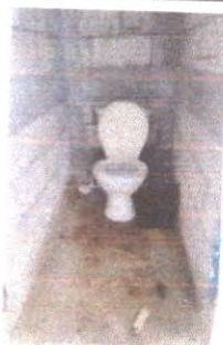
Foto 7: sustitución de inodoros (tasas)
