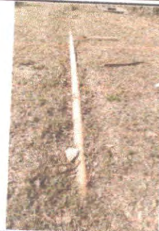
Foto 14: sustitución de tubería de aguas negras
