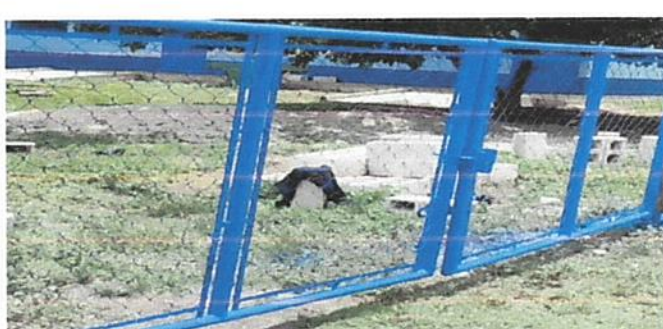
MANTENIMIENTO A PORTÓN
