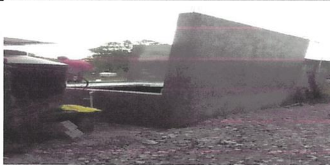
REPARACION EN MURO DE CONTENCIÓN
