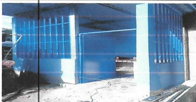
SUSTITUCIÓN DE BALCON
