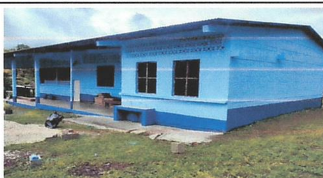
PINTURA EN EXTERIOR E INTERIOR
