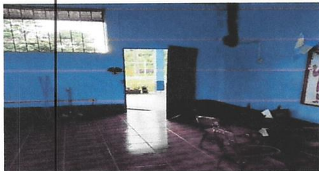
MANTENIMIENTO A ESTRUCTURA
