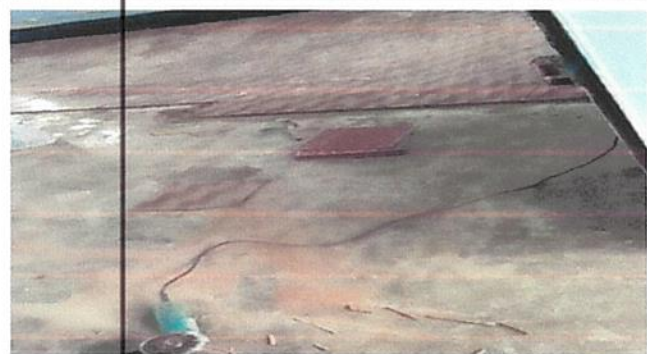
SUSTITUCIÓN DE CERAMICA
