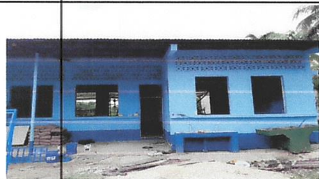
SUSTITUCIÓN DE BALCON
