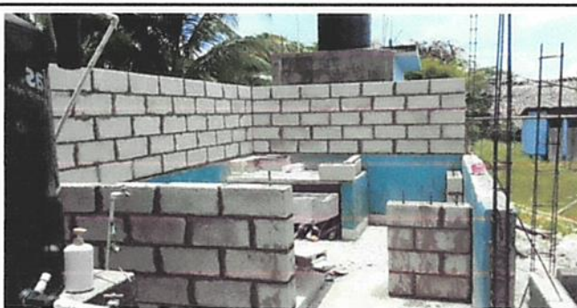
REPARACION EN MURO DE CONTENCIÓN
