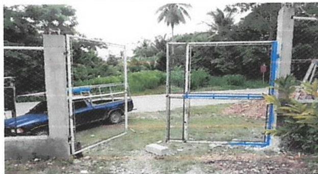
MANTENIMIENTO A PORTON
