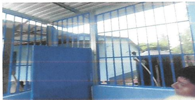
MANTENIMIENTO A ESTRUCTURA DE METAL DE VENTANA
