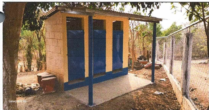
FOTO 5: VISTA FRONTAL DE BAÑOS MEJORADOS
