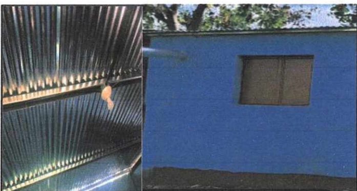
Foto 6: SUSTITUCION DE LAMINA POR LAMINA y MEJORAMIENTO DE ESTRUCTURA DE SOPORTE DE METAL
