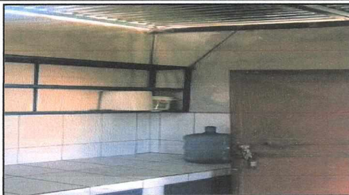
Foto 2: REPARACION DE AZULEJO EN MUEBLE DE COCINA, SUSTITUCION DE ESTUFA RURAL COMPLETA INCLUYE CHIMENEA Y PLANCA DE METAL
