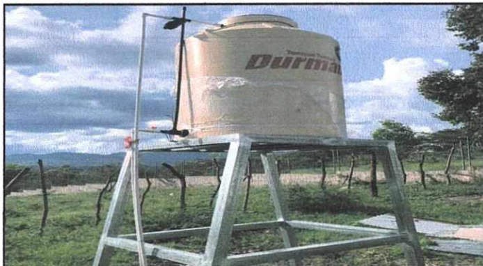
Foto 4: REPARACION Y MANTENIMIENTO DE CISTERNA, DEPOSITO DE AGUA
