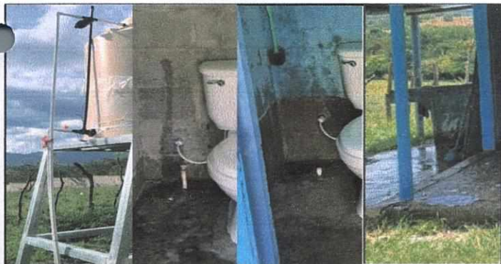
Foto 5: INSTALACION DE TUBERIA PVC, INSTALACION DE CHORROS
