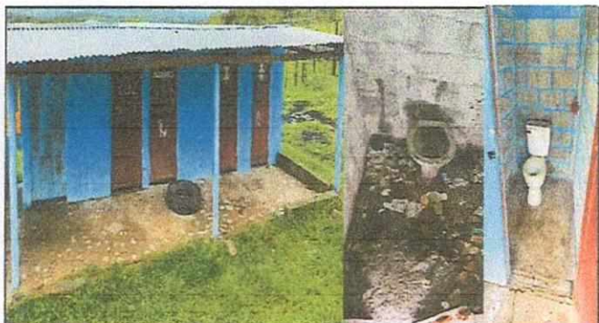
Foto 3: MEJORAMIENTO FABRICACION E INSTALACION DE PUERTA EN SERVICIO SANITARIO
