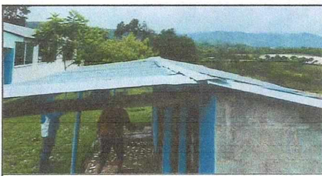
Foto 6: SUSTITUCION DE LAMINA POR LAMINA y MEJORAMIENTO DE ESTRUCTURA DE SOPORTE DE METAL
