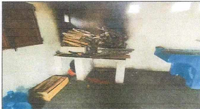
Foto 2: REPACION DE AZULEJO EN MUEBLE DE COCINA, SUSTITUCION DE ESTUFA RURAL COMPLETA INCLUYE CHIMENEA Y PLANCA DE METAL
