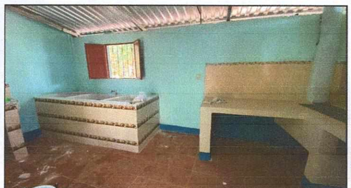
Foto 4: REPARACION DE COCINA, MEJORAMIENT DE ESTUFA RURAL
