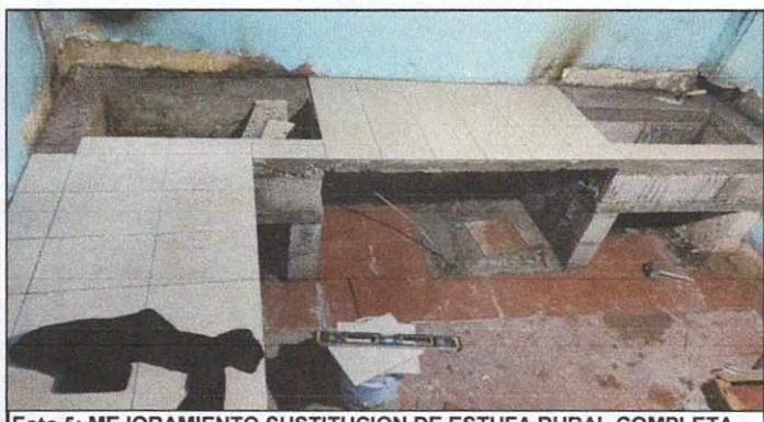
Foto 5: MEJORAMIENTO SUSTITUCION DE ESTUFA RURAL COMPLETA INCLUYE CHIMENEA Y PLANCA DE METAL
