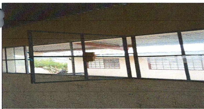
VIDROS DE VENTANERIA A CAMBIADOS
