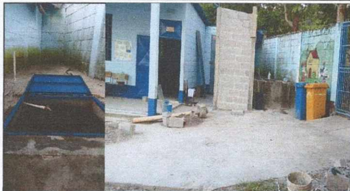
Foto 7: Mantenimiento de caja de registro, sustitución de tubería PVC, línea principal, agua negras, reparación de tapaderas de cajas, mantenimiento reposadera, limpieza de fosa séptica
