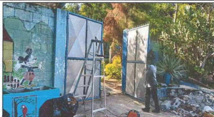
Foto 8: Mantenimiento y mejoramiento de portón de metal,
