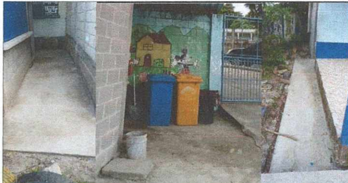
Foto 10: Mejoramiento banquetas, y losa en la entrada de la cocina, y entrada principal
