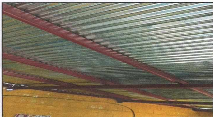
Foto 3: Sustitución de lámina, por lámina troquelada, Sustitución de estructura de soporte de metal, por metal
