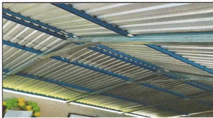
Foto 4: Mejormiento a estructura de soporte de metal Desinstalación de estructura portante
