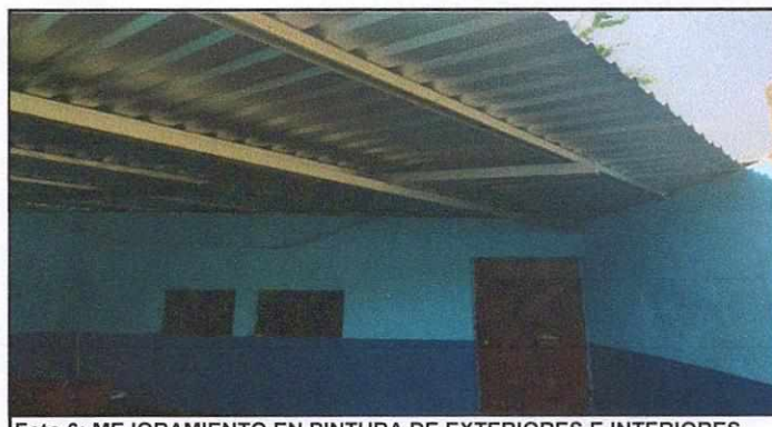
Foto 6: MEJORAMIENTO EN PINTURA DE EXTERIORES E INTERIORES PINTURA AGUA
