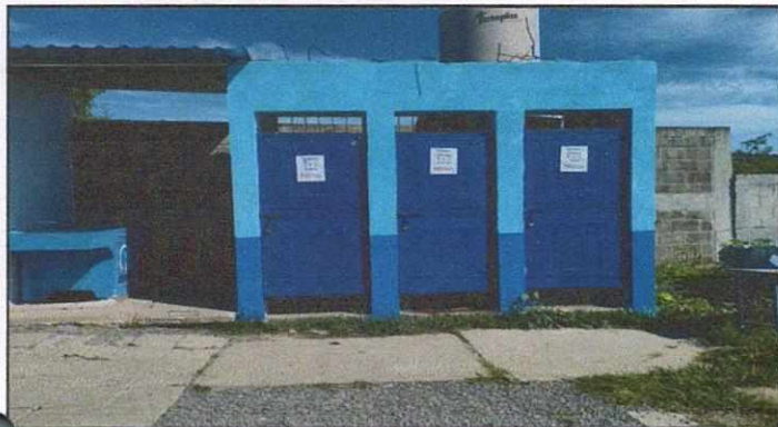
Foto1:SERVICIOS SANITARIOS Y SUS ACCESORIOS, Mejoramiento de Paredes de Baños, Sustitución inodoro e Instalacion de Baños,
