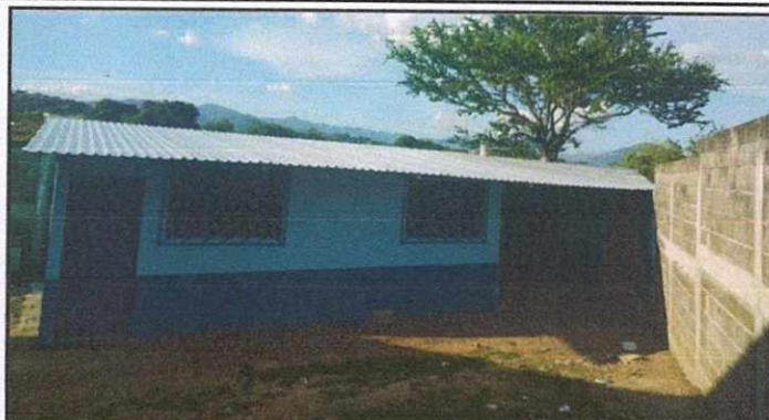
Foto 2: COCINA, Mejoramiento de Paredes de Cocina 60 mts2 en la cocina block, 850, cemento 75, Reparación de piso cerámico,
