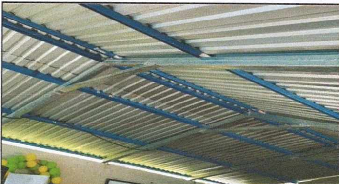
Foto 4: Mejoramiento a estructura de soporte de metal. Desinstalación de estructura portante
