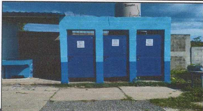
Foto 1: SERVICIOS SANITARIOS Y SUS ACCESORIOS, Mejoramiento de Paredes de Baños, Sustitución inodoro e Instalación de Baños,
