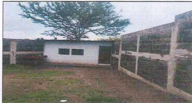
Foto 2: COCINA, Mejora de Paredes de Cocina 60 mts2 en la cocina block, 850, cemento 75, Reparación de piso cerámico,
