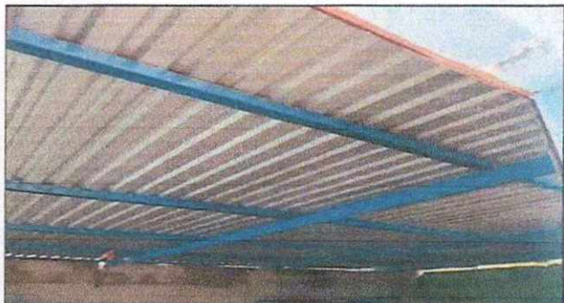
Foto 4: Mejora a estructura de soporte de metal Desinstalación de estructura portante
