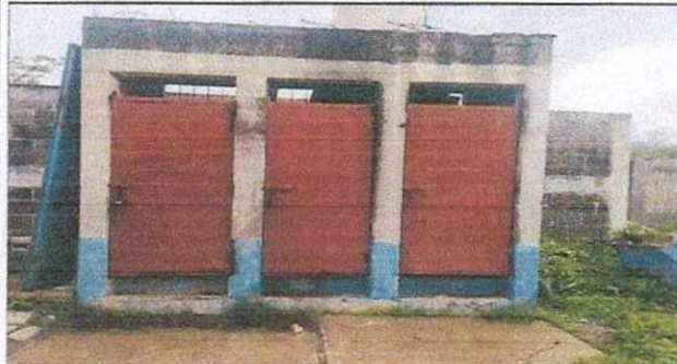
Foto 1: SERVICIOS SANITARIOS Y SUS ACCESORIOS, Mejora de Paredes de Baños, Sustitución inodoro e Instalación de Baños,
