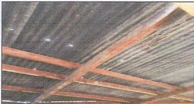
Foto 3: Sustitución de lámina, reparación de estructura de soporte de metal, pintura
