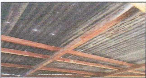
Foto 5: Desinstalación de lámina existente Y Sustitución de lámina.
