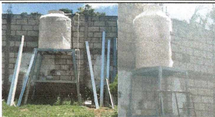
Foto2: REPARACION Y MANTENIMIENTO DE CISTERNA, DEPOSITO DE AGUA.
