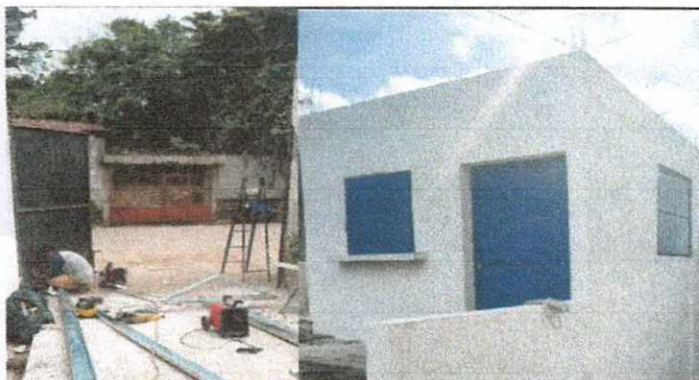
Foto3: MEJORAMIENTO DE PUERTA DE METAL.
