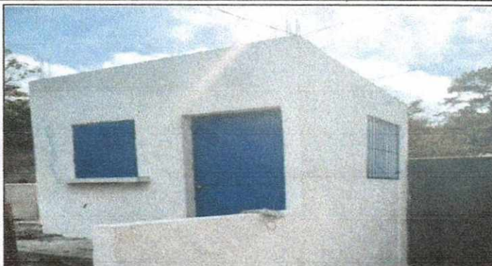
Foto1: MEJORAMIENTO REPARACION DE MURO DE COCINA, MEJORAMIENTO DE ESTUFA RUTAL.
