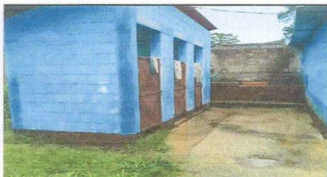
Foto 3: MEJORAMIENTO DE PUERTAS DE METAL
