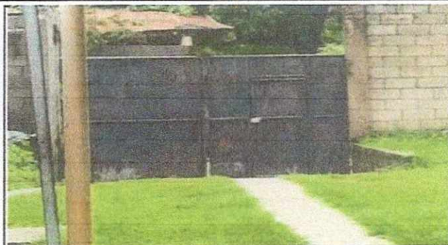
Foto 8: Mejoramiento a estructura (lijado, cambio de tubo, cepillado, sujeciones, aplicación de pintura)
