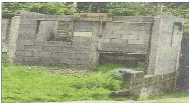
Foto 4: SUSTITUCION DE ESTRUCTURA DE METAL EN VENTANA
