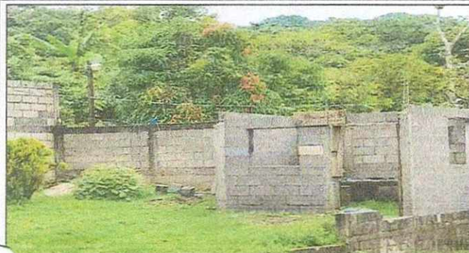
Foto 1: MEJORAMIENTO REPARACION DE MURO DE COCINA, MEJORAMIENTO DE ESTUFA RURAL
