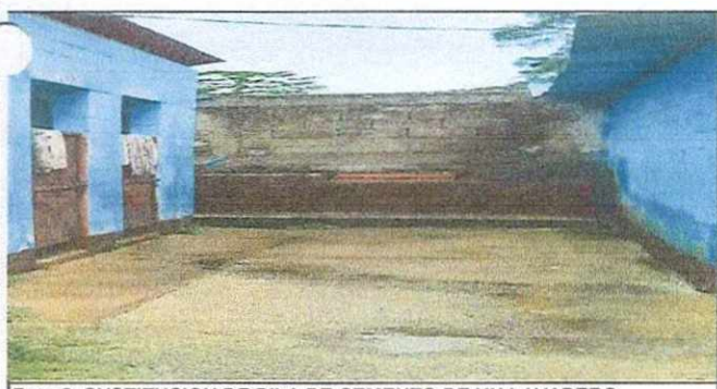
Foto 5: SUSTITUCION DE PILA DE CEMENTO DE UN LAVADERO
