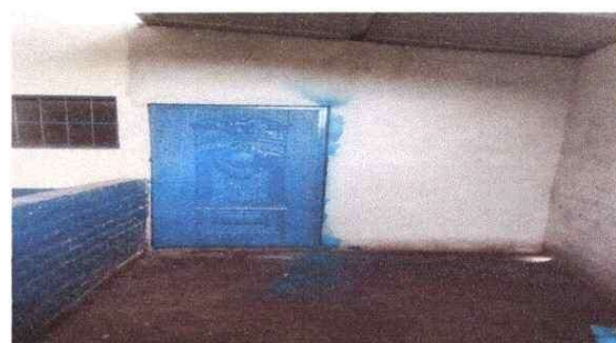
Foto 4: SUSTITUCION DE PUERTAS
