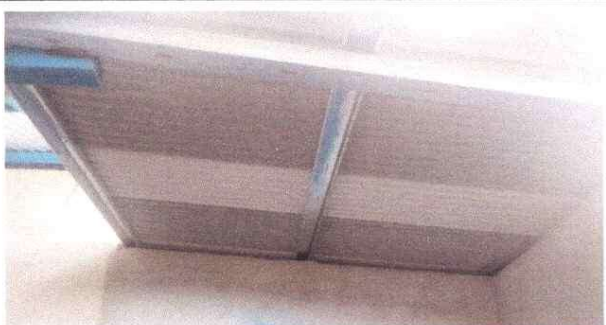
Foto 5: SUSTITUCION DE LAMINA POR LAMINA TROQUELADA CALIBRE 26
