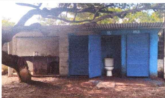
Foto1: INSTALACION DE INIDOROS
