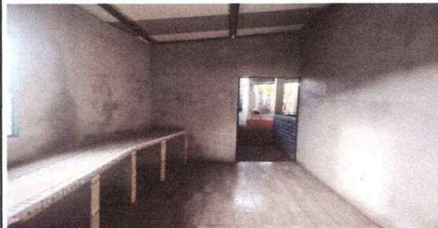
Foto 6: SUSTITUCION DE PISO CERAMICO
