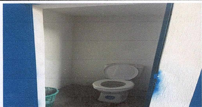
Foto 5: SUSTITUCION DE SANITARIOS
