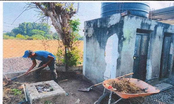
FOTO 2: PROCESO DE SUSTITUCION DE SANITARIOS
