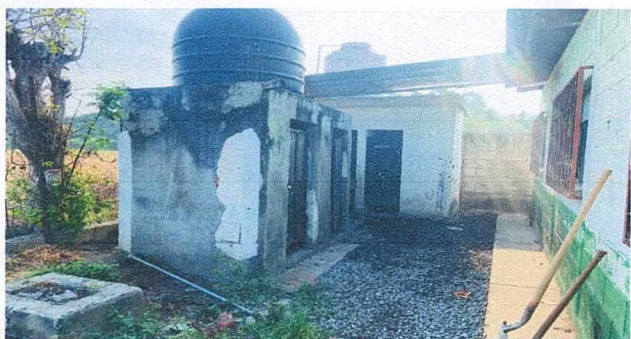
FOTO 1: SUSTITUCION DE SANITARIOS
