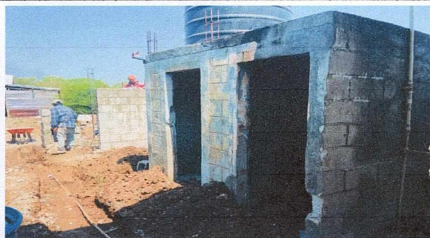
FOTO 5: AVANCE DE REMODELACION DE SANITARIOS
