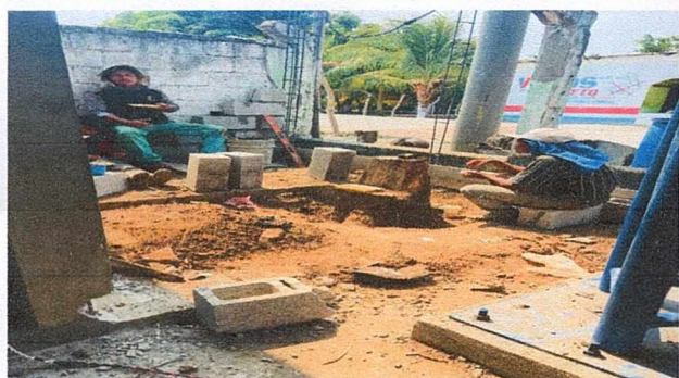
FOTO 3: MEJORAMIENTO DE BODEGA DE ESCUELA
