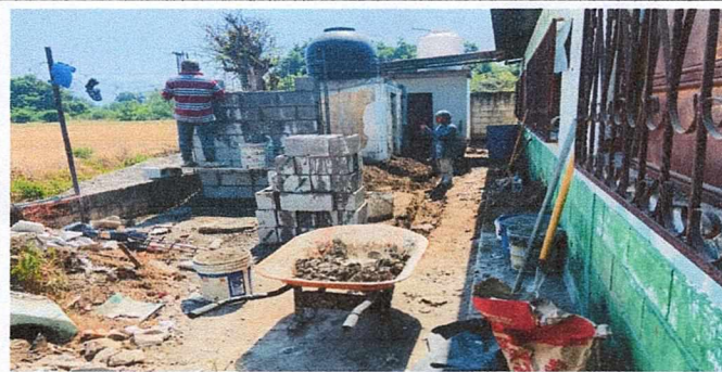
FOTO 6: AVANCE DE FUNDICION DE PILA
