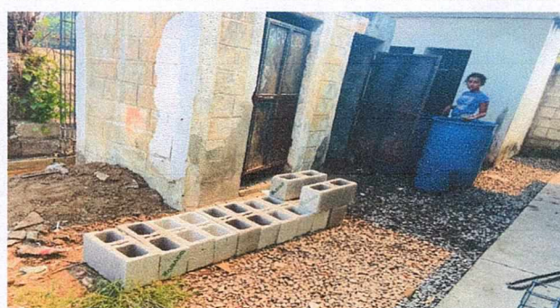
FOTO 4: AVANCE SE SUSTITUCION DE SANITARIOS
