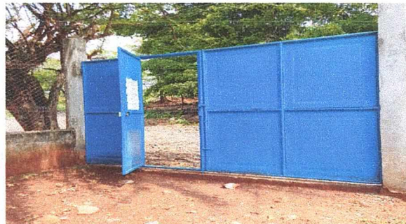
Foto 4: SUSTITUCION DE PORTON DE METAL CON SU REPECTIVA CHAPA
