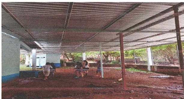
Foto1: MEJORAMIENTO DE TECHO DE GALERA PARA PATIO DE ESCUELA
