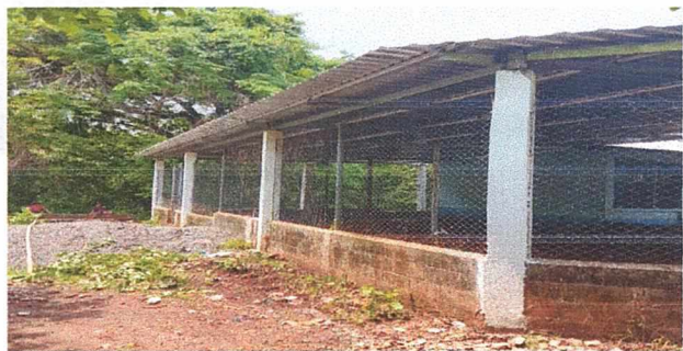
Foto 3: MEJORAMIENTO DE TECHO DE GALERA PARA PATIO
