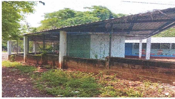
Foto 2: MEJORAMIENTO DE TECHO DE GALERA PARA PATIO DE ESCUELA
