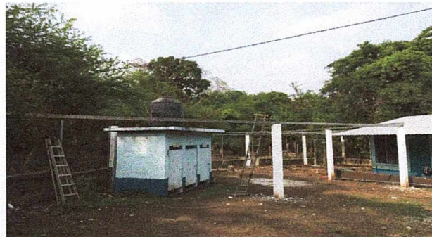
TECHADO DE PATIO
