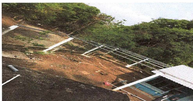
PROCESO DE SUSTITUCION DE TECHO PARA PATIO
