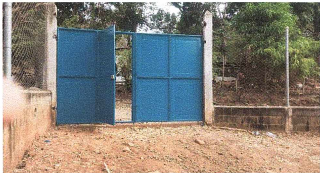
SUSTITUCION DE PORTON DE ENTRADA PRINCIPAL DE ESCUELA
