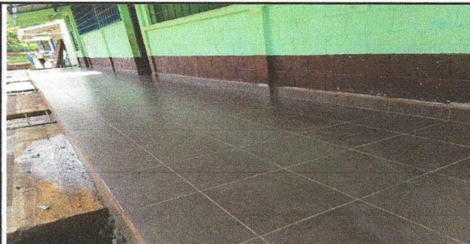
Foto 2: COLOCACION DE PISO CERRAMICO DE CORREDOR DE ESCUELA.
