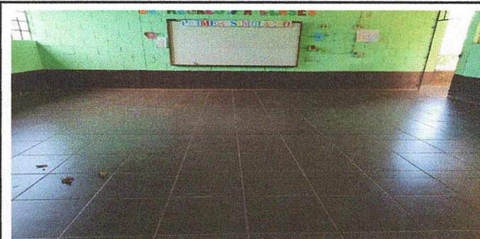
Foto 4: COLOCACION DE PISO CERRAMICO EN AULAS.
