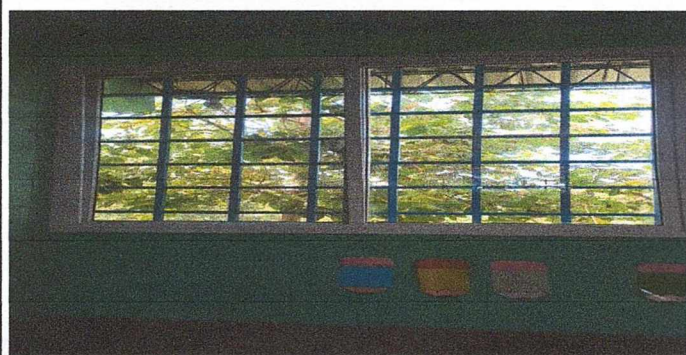
Foto1: COLOCACION DE VENTANAS DE PVC EN AULAS.
