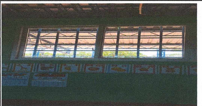
Foto 5: COLOCACION DE VENTANAS PVC.
