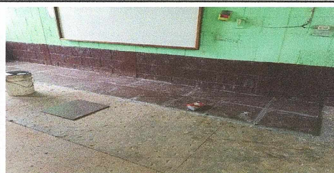
Foto 4: COLOCACION DE PISO
