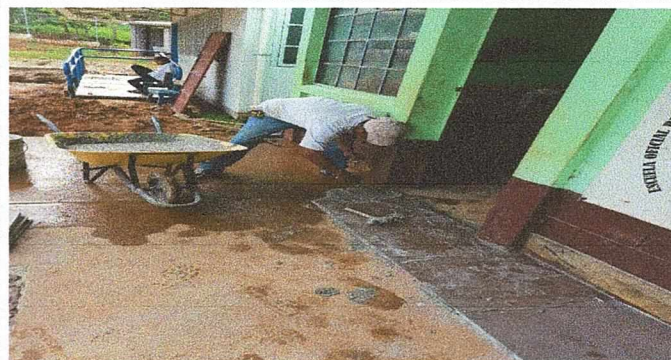
Foto :COLOCACION DE PISO CERAMICO EN CORREDOR DE ESCUELA.
