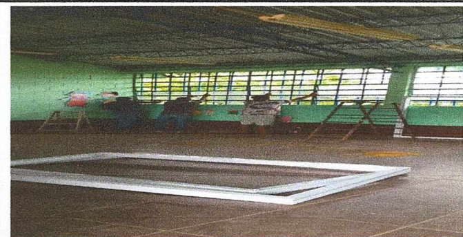
Foto 6: COLOCACION DE VENTANAS.
