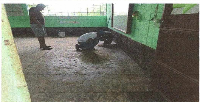
Foto 3: COLOCACION DE PISO CERAMICO EN AULAS
