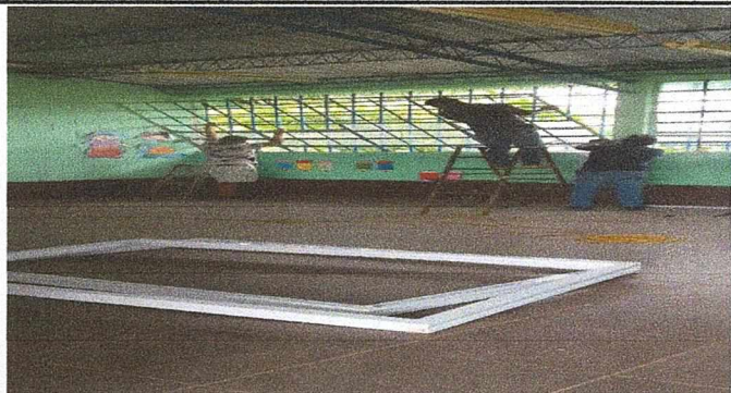
Foto1: INSTALACION DE VENTANAS PVC.
