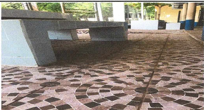
Foto 3: SUSTITUCION DE PISO DE TORTA POR CERAMICO ANTIDESLIZANTE.
