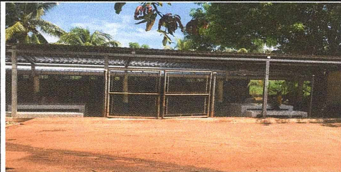
Foto 6: PATIO COMPLETAMENTE TECHADO.
