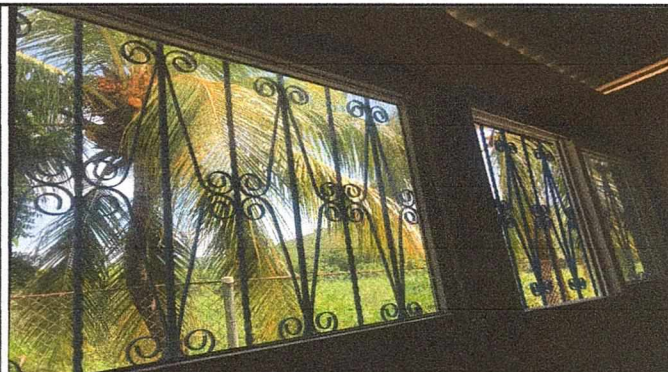
Foto 4: COLOCACION DE VENTANALES PARA VENTANA.
