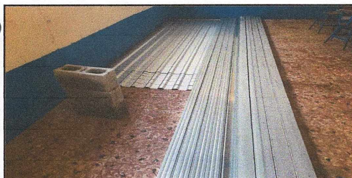
Foto 5: LAMINA PARA TECHO DE PATIO
