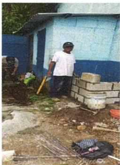
Foto1: Se cambió renglón de instalación de lavamanos en cocina por fabricación de lavamanos de cemento en area de sanitarios el cual esta en proceso.
