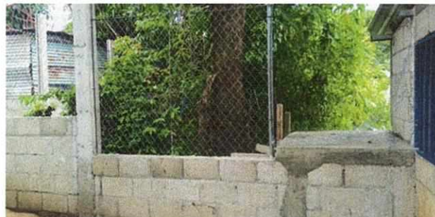
Foto 2: Preparación de soporte de block y cemento para ubicar el tinaco que abastecerá a cocina y sanitarios de Párvulos.
