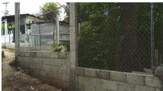
Foto 5: Mejoramiento de muro perimetral en proceso de colocación de malla metálica en area de párvulos
