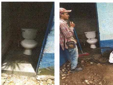
Foto 3: Sustitución de sanitarios tipo letrina de plástico por sanitarios lavables de cerámica en párvulos en proceso de pruebas.
