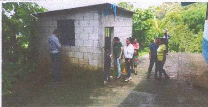
Foto 1: Area de cocina para instalación de tinaco de captación de agua.
