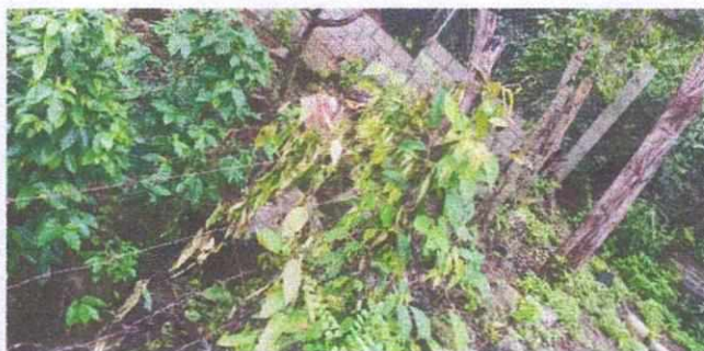
Foto 6: Muro perimetral dañado para mejorar con block, cemento y malla metálica.
