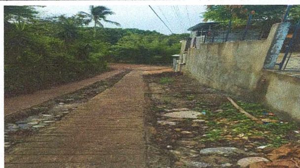
Foto 4: MURO DE CONTENCIÓN REPARADO
