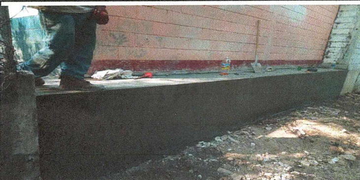
Foto 3: REPARACION DE SOCABAMIENTO DE SIEMENTOS DE PARED DE AULAS
