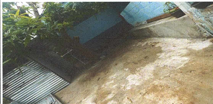
Foto 1: TECHO DE COCINA Y LOZA DE PATIO TERMINADOS
