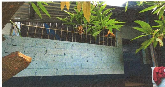
Foto 2: PEQUEÑO TECHO EN SUSTITUCION POR CANAL DE METAL
