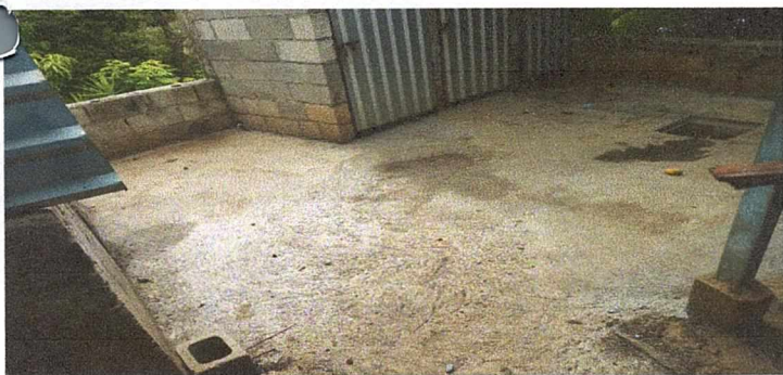
Foto 5: LOZA DE PATIO REPARADA
