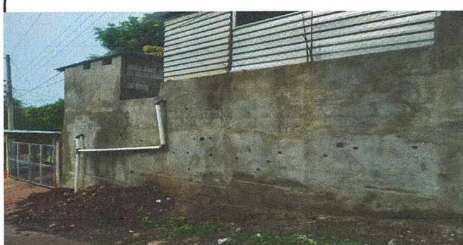
Foto 6: AGUAS PLUVIALES CONECTADAS EN LUGAR CORRECTO
