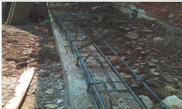
Foto 1: REALIZANDO REPARACION DE MURO PERIMETRAL
