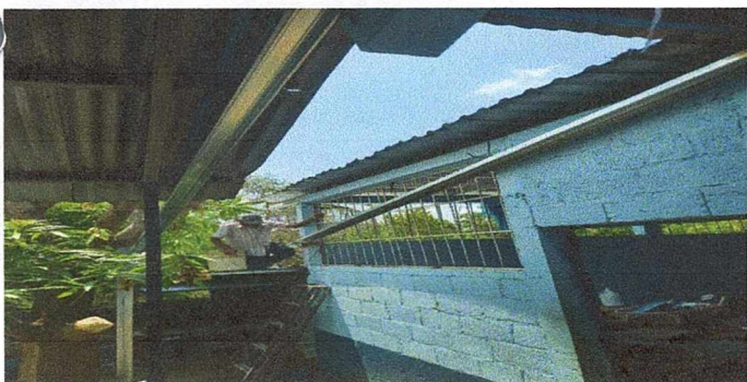
Foto 5: SUSTITUCION DE CANAL DE METAL Y REPARACION DE TECHO DE COCINA
