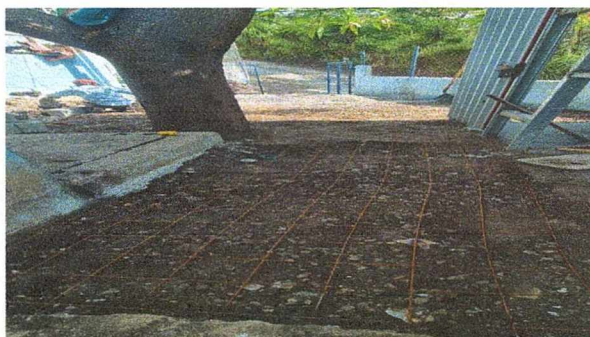
Foto 4: REPARANDO LOZA DE PATIO
