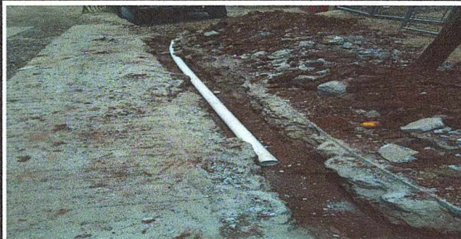
Foto 2: ENCAUSANDO AGUAS PLUVIALES
