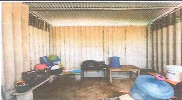
Foto 3. Mejoramiento de piso de cocina
