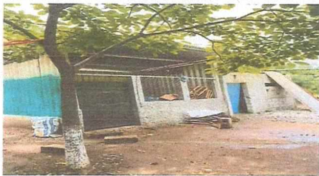
Foto 1. Reparación y mejora de paredes de cocina
