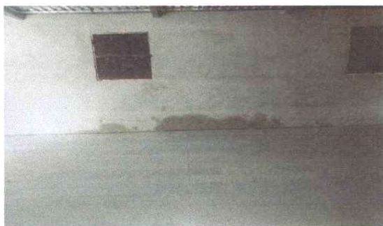
Foto 3: Módulo Aula: Paredes y piso de cemento en mal estado (Reparación de grietas , repello y sustitución de torta por piso cerámico) en area de corredor.
