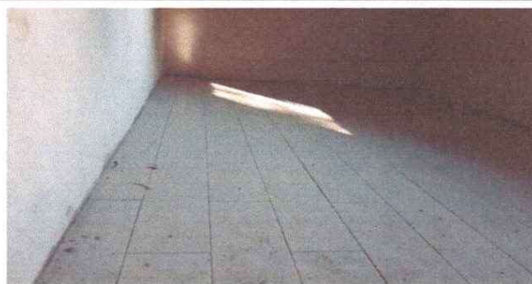
Foto 2: Módulo Cocina: Torta de cocina en mal estado para sustituir con piso cerámico, paredes dañadas a mejorar y para apertura de ventanas.
