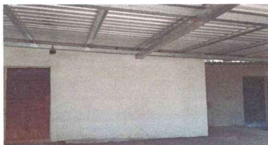
Foto 5: Módulo anexa a Cocina: Sustitución de lámina en mal estado por lámina troquelada calibre 26, sustitución de estructura portante de madera por estructura metalica galvanizada y cambio de pilares de madera por metal galvanizado. Area externa/anexa a cocina donde se encuentra pila de cemento
