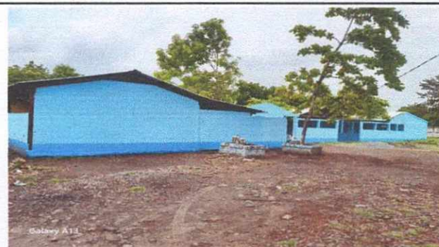
Foto 4: Pintura exterior finalizada
