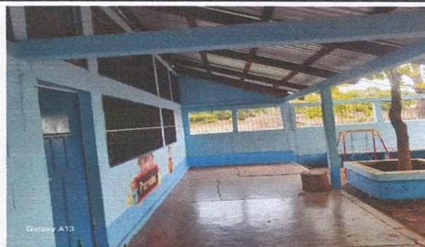
Foto 4: Corredor pintura, techo y barroteado finalizado
