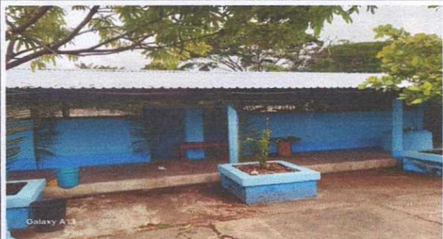
Foto 1: Instalacion de Techo finalizado
