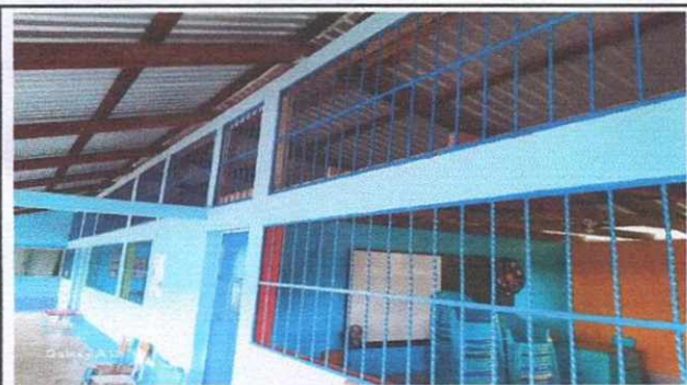
Foto 3: Instalacion de balcones finalizado
