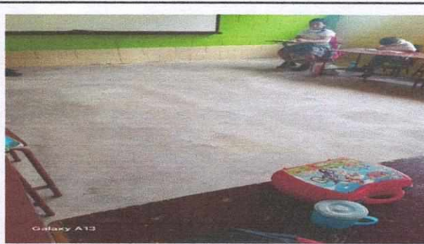
Foto 2: Entortado de aulas finalizado
