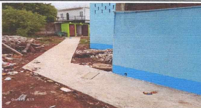
Foto 1: Encementado camino hacia los baños finalizado
