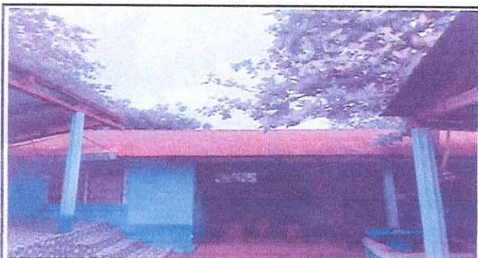
Foto 3: CAMBIO DE TECHO DE LOS SALONES
