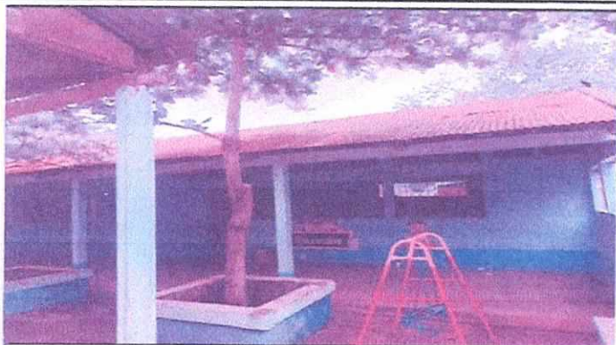
Foto 1: CAMBIO DE TECHO DE LOS SALONES
