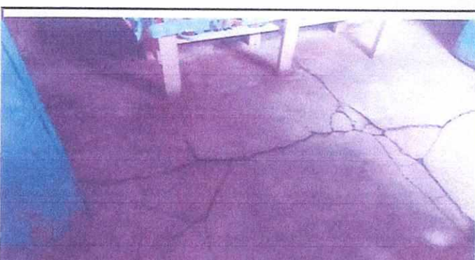
Foto 4: ENTORTADO NUEVO PARA LA COCINA
