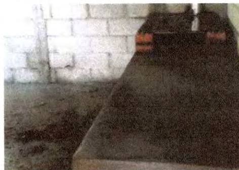
Foto 4: Trabajos completados de mejoramiento de poltón e instalacion de plancha y chimenea.
