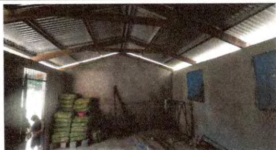
Foto 15: Repello de pared interior y exterior de aula culminado.
