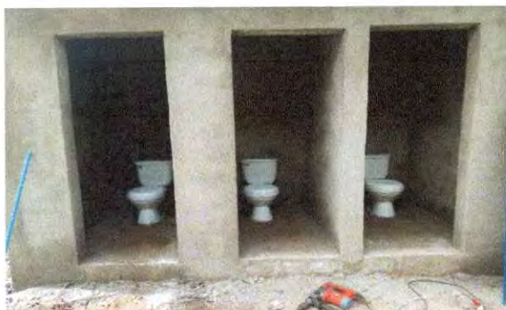
Foto 09: Sustitución de sanitarios lavables de porcelana en mal estado por nuevos realizada.
