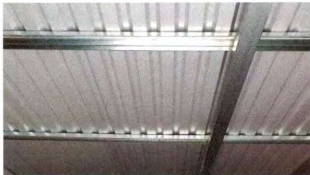
Foto1: Sustitución de estructura de madera en mal estado por estructura de metal galvanizada en cocina culminado
