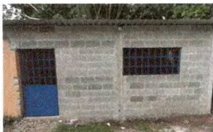
Foto 19: Sustrución de puerta de madera en mal estado por puerta de metal en cocina culminado
