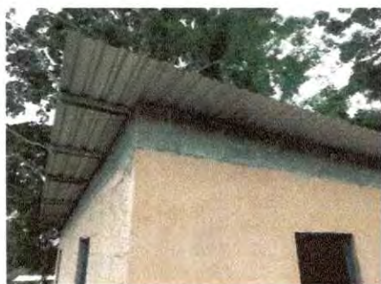
Foto 21. Levantamiento de los iladas de block en cuatro paredes de un aula finalizado.
