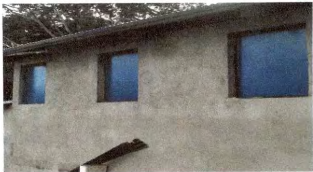
Foto 13: Finalización de Mejoramiento de ventanas ( lijado, soldadura y pintura ) en aula completado.
