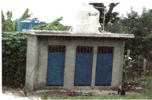
Foto 10: Sustitución de puertas de madera en mal estado por puertas nuevas de metal, culminado.
