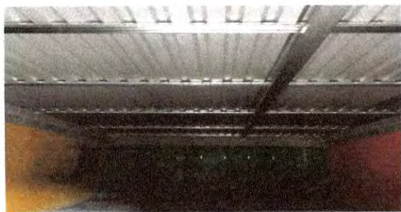
Foto 17: Sustitución de lámina en mal estado por lamina troquelada calibre 26 en aula, completada.
