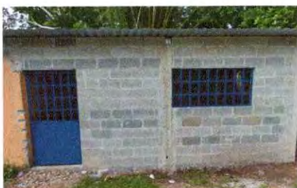
Foto 19: Sustrucción de puerta de madera en mal estado por puerta de metal en cocina culminado
