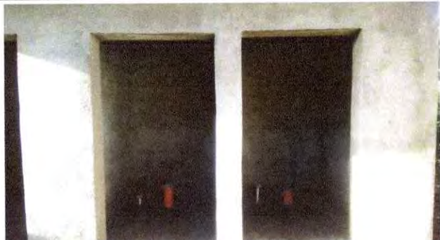
Foto 07: Mejoramiento de paredes de baños completados.
