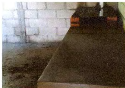
Foto 4: Trabajos completados de mejoramiento de polletón e instalacion de plancha y chimenea.
