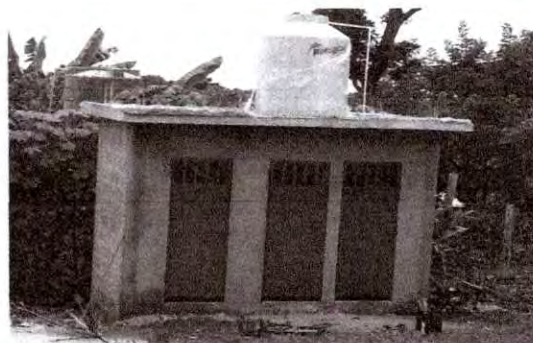
Foto 10: Sustitución de puertas de madera en mal estado por puertas nuevas de metal, culminado.
