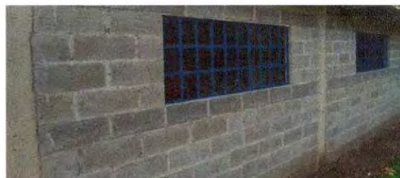
Foto 22: Sustrucción de ventanas de malla por ventanas de rejas de metal culminado.
