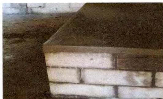
Foto 20: Mesa de cemento en area de cocina, terminada.
