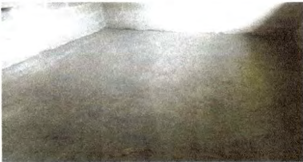
Foto 5: Mejoramiento de torta rústica de cemento en cocina completado.
