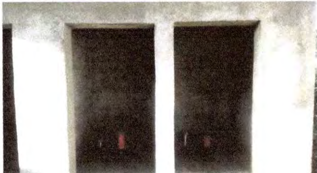
Foto 07: Mejoramiento de paredes de baños completados.
