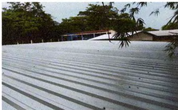
Foto 2: Trabajos finalizados de sustitución de lámina en mal estado por lámina troquelada calibre 26 en cocina
