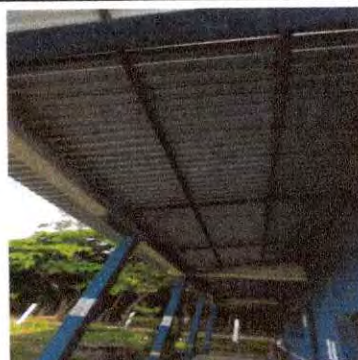
Foto 16: Mejoramiento de estructura metálica en aulas (lijado y pintura), concluido.
