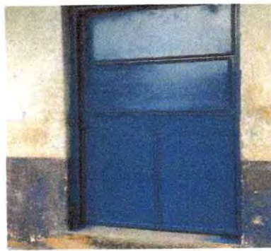
Foto 14: Mantenimiento puerta metálica ( lijado y pintura ) en aula completado.
