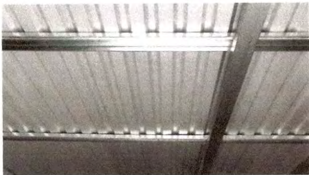
Foto1: Sustrucción de estructura de madera en mal estado por estructura de metal galvanizada en cocina culminado
