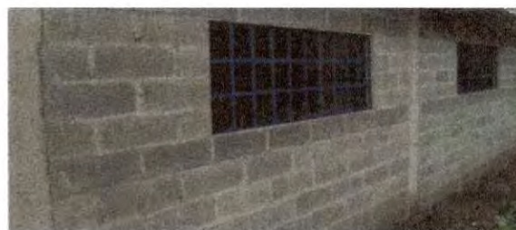
Foto 22: Sustrución de ventanas de malla por ventanas de rejas de metal culminado.
