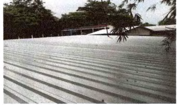
Foto 2: Trabajos finalizados de sustrucción de lámina en mal estado por lámina troquelada calibre 26 en cocina
