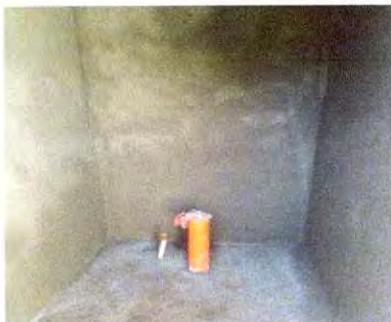
Foto 11: Reparación de paredes de sanitario y de tubería de montaje/conexión de sanitario lavable de cerámica, finalizado.
