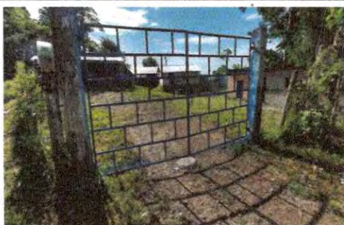
Foto 17: Detalles finales de mejoramiento de portón principal.
