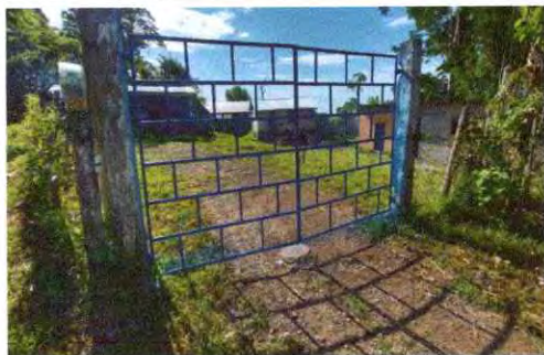
Foto 17: Detalles finales de mejoramiento de portón principal.
