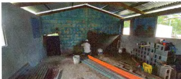
Foto 7: Mejoramiento de paredes de aula en proceso.
