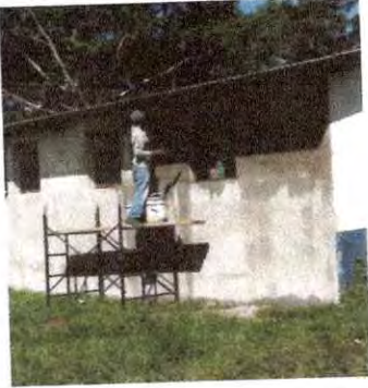
Foto 1: Etapa de mejoramiento de pared de block de cocina.
