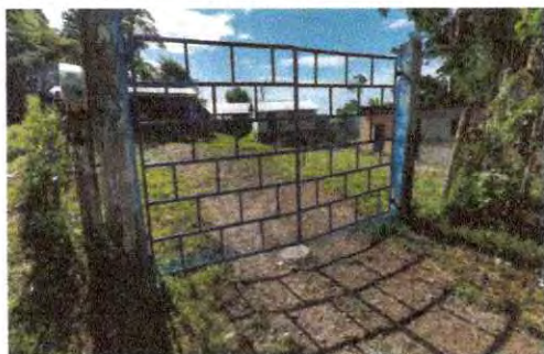
Foto 17: Detalles finales de mejoramiento de portón principal.
