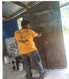
Foto 14: Ejecución de trabajos iniciales de mantenimiento de puertas metálicas(lijado, pintura y soldadura) en aulas.
