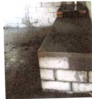
Foto 6: Detalles finales de mejoramiento de polletón de cemento con plancha metálica y chimenea.
