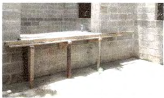
Foto 14: fundicion de mezon en la cocina en proceso.
