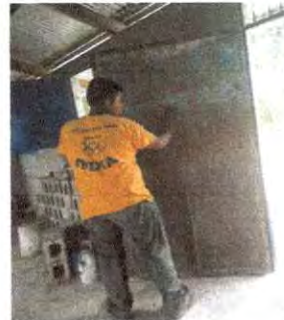
Foto 14: Ejecución de trabajos iniciales de mantenimiento de puertas metálicas(lijado, pintura y soldadura) en aulas.
