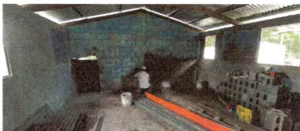
Foto 7: Mejoramiento de paredes de aula en proceso.
