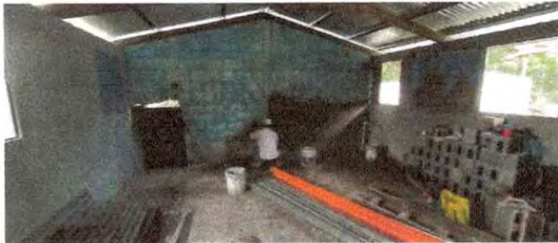
Foto 7: Mejoramiento de paredes de aula en proceso.
