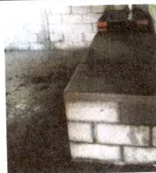
Foto 6: Detalles finales de mejoramiento de polletón de cemento con plancha metálica y chimenea.
