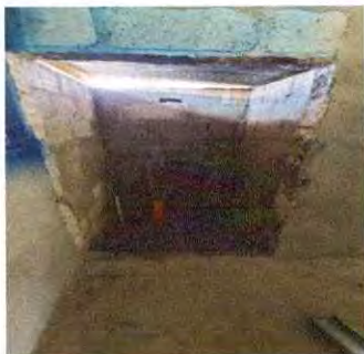
Foto13: sellar y abrir puerta en block en sanitarios en proceso .
