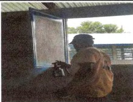
Foto 15: Proceso de mejoramiento de ventanas de aula con pintura, lijado y soldadura.
