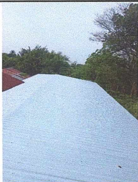
Foto 1: Colocación de láminas en aulas finalizado
