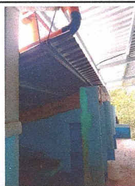
Foto 6: Instalación de estructura metálica y lámina en techo de cocina finalizado
