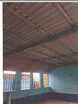
Foto 4: Levantado de mojinetes, repello de aulas, colocación de estructura metálica y láminas en aulas finalizado
