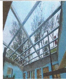
Foto 4: Instalación de estructura metálica en aula
