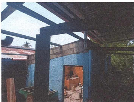
Foto 5: Se sustituyó la reparación de ventanas debido a que el techo de la cocina también se encontraba en mal estado por lo que se inició con levantado de mojinetes
