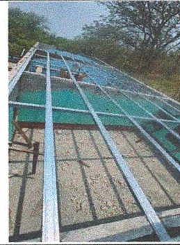
Foto 2: Instalación de estructura metálica en aulas
