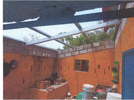
Foto 6: Instalación de estructura metálica en la cocina
