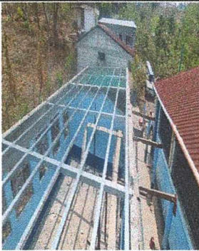
Foto 3: Instalación de estructura metálica en tres aulas
