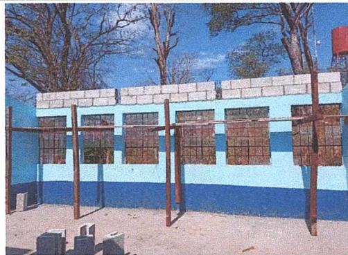
Foto 2: Levantado de mojinetes en aulas
