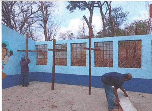
Foto1: Retiro de láminas vigas de madera en aulas y corredor
