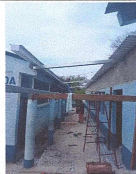
Foto 4: Instalación de estructura metálica en corredor y colocación de estructura y lámina en aulas
