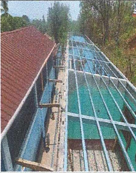
Foto 1: Instalación de estructura metálica en tres aulas
