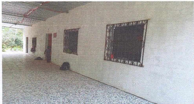
Foto1: Cambio de piso culminado
