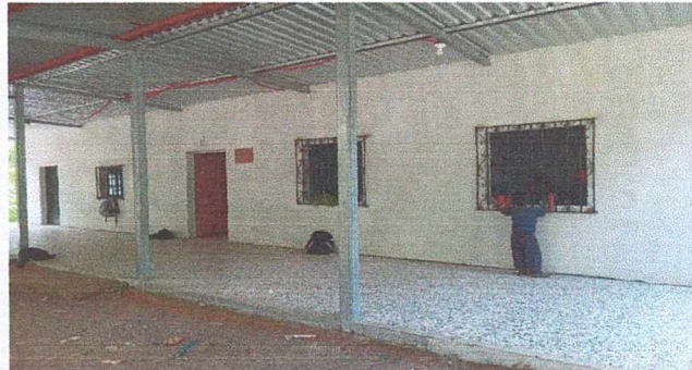
Foto2: Cambio de piso culminado
