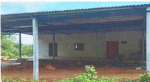
Foto3: Techo terminado traspatio
