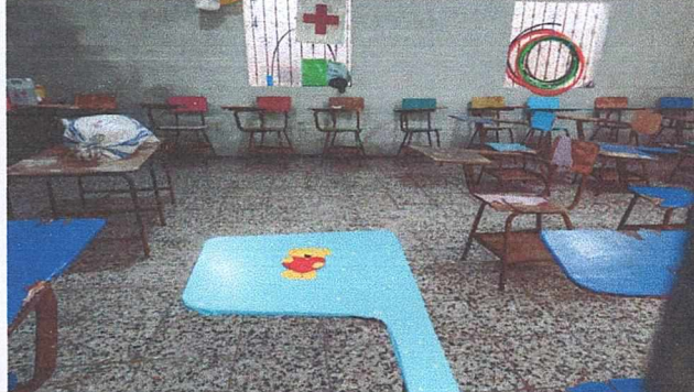
Foto4: cambio de piso de aula terminado
