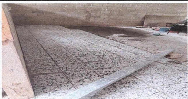
Foto5: Cambio de piso torta por piso granito el 70%
