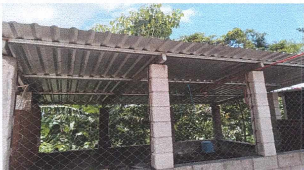
Foto1: Techo cocina terminado
