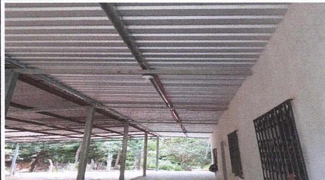
Foto4: cambio de pilares terminado
