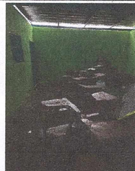
Foto 2: Mejoramiento de techo y pared en una aula
