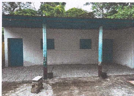
Foto 1: Mejoramiento de repello y techo
