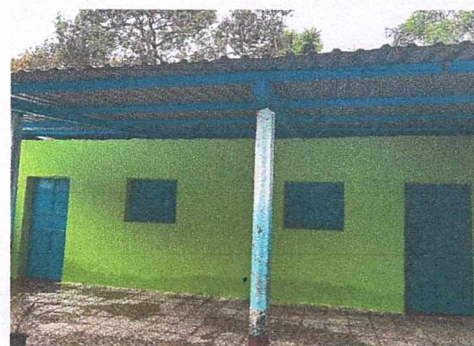
Foto 6: Mejoramiento de pintura, puertas y ventanas
