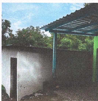
Foto 3: Mejoramiento de costaneras
