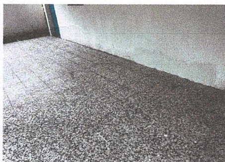
Foto 5: Instalacion de piso de granito en corredor y cocina
