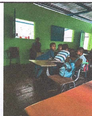
Foto 4: Instalacion de ventanas de metal y piso
