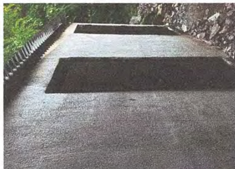
Foto 4: Mejoramiento de repello en paredes y instalacion de puertas de metal
