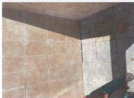
Foto 6: Instalacion de piso y asulejo en los sanitarios
