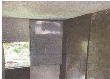
Foto 2: Instalacion de piso ceamico
