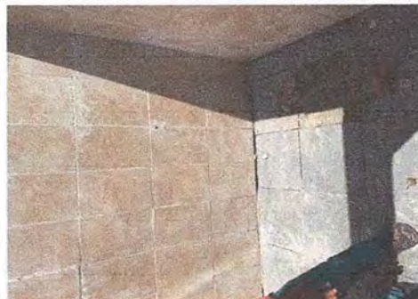
Foto 6: Instalacion de piso y asulejo en los sanitarios
