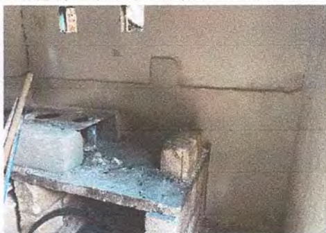
Foto 5: Mejoramiento de cocina
