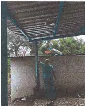
Foto 1: Instalacion de techo en aulas
