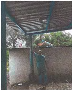
Foto1: Instalacion de techo en aulas
