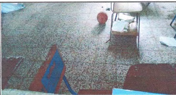
Foto 5: Piso módulo de aula 1
