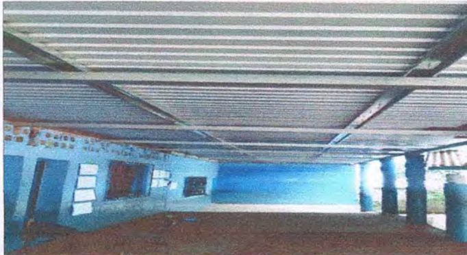
Foto 4: Techo corredor de 3 aulas
