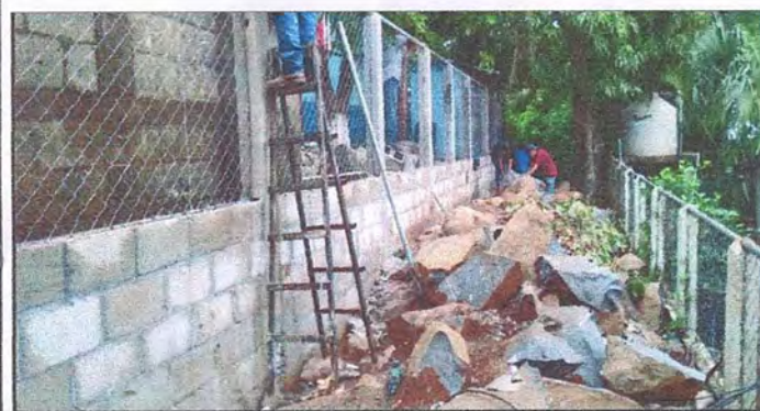
Foto 5: Mejoramiento de muro perimetral
