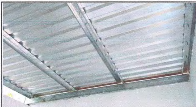
Foto 2: Techo de cocina
