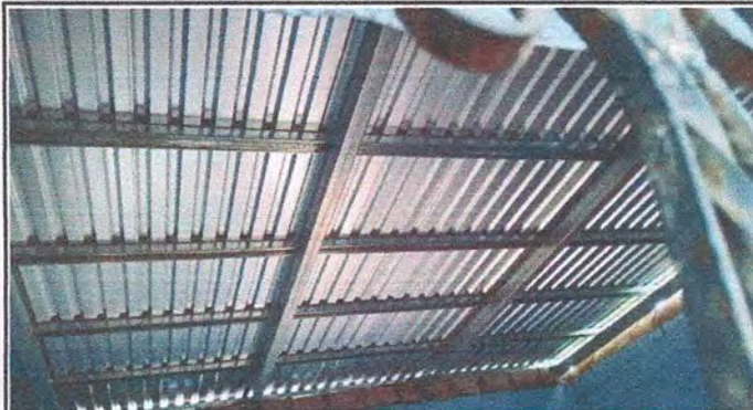
Foto 2: Techo de Módulo de aula 2
