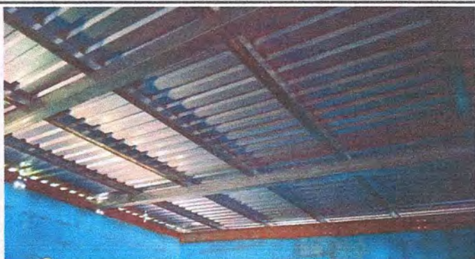
Foto 1: Techo de Módulo de aula 1
