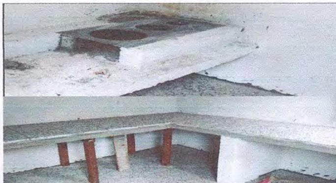
Foto 4: Mejoramiento de polletón de cocina y elaboración de plancha de cemento en área de cocina
