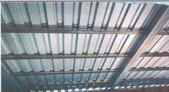
Foto 3: Techo de Módulo de aula 3
