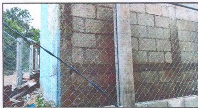
Foto 6: Mejoramiento de muro perimetral
