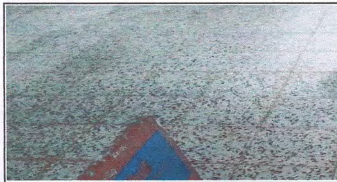
Foto 6: Piso módulo de aula 2
