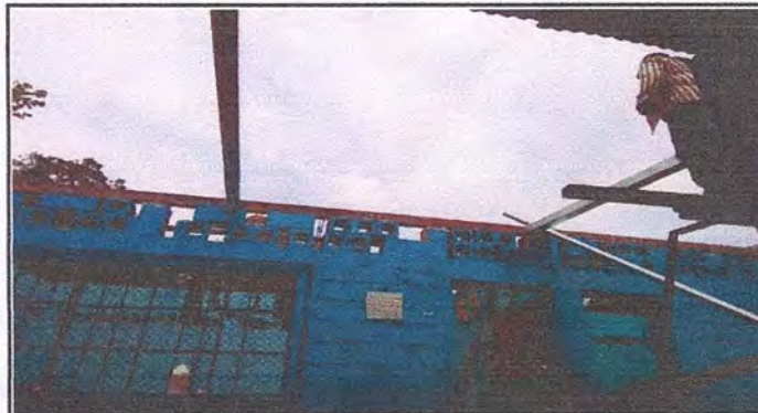
Foto 4: Techo de corredor de 3 aulas
