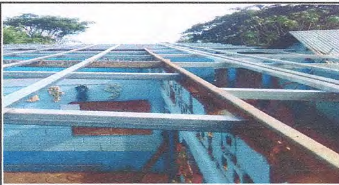
Foto 2: Techo de cocina
