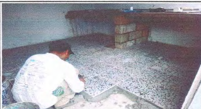
Foto1: Piso Modulo de cocina
