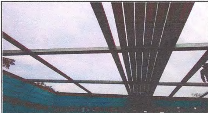
Foto 2: Techo módulos de aulas 2
