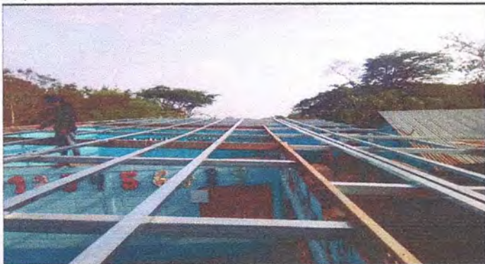
Foto1: Techo módulos de aulas 1
