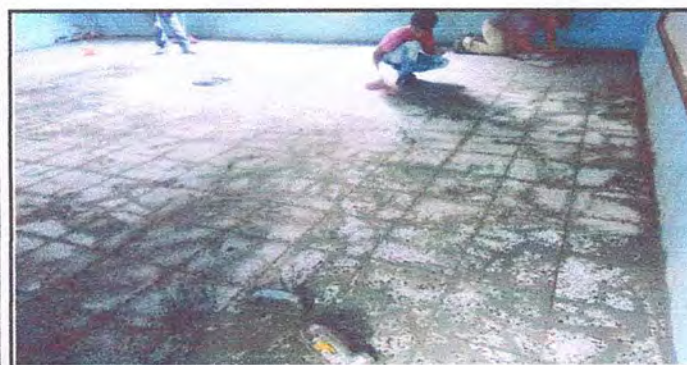
Foto 5: Piso módulo de aula 1
