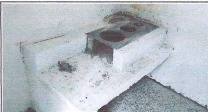
Foto 4: Mejoramiento de polletón de cocina
