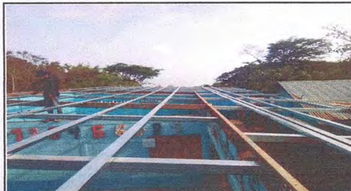
Foto 3: Techo módulos de aulas 3
