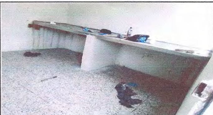
Foto 3: Repello de paredes interiores de cocina
